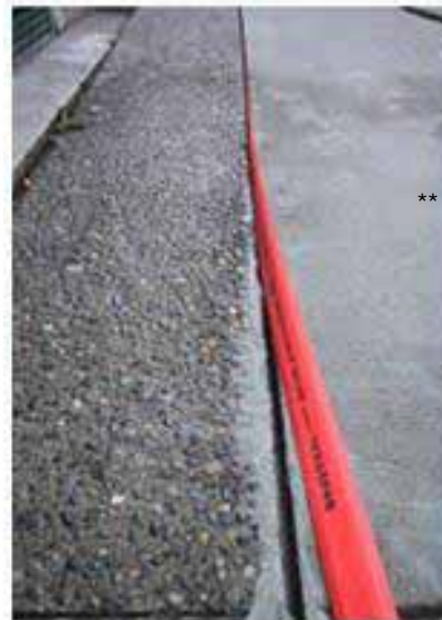
Laying the conduit
