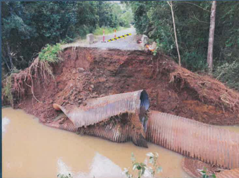
Keerrong Rd: Culvert washout
