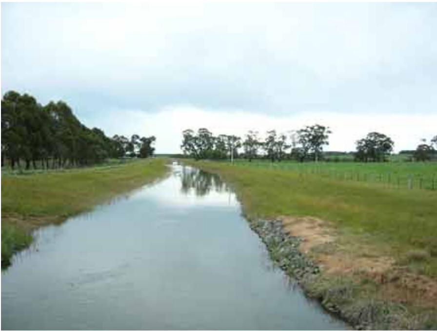
Wurdee Boluc Aquaduct south west of Geelong.
